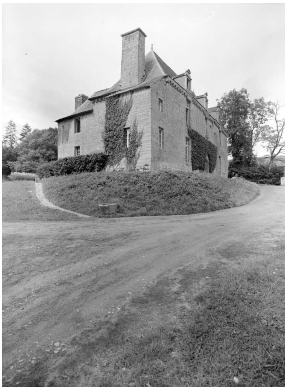
Vue prise du sud-ouest
