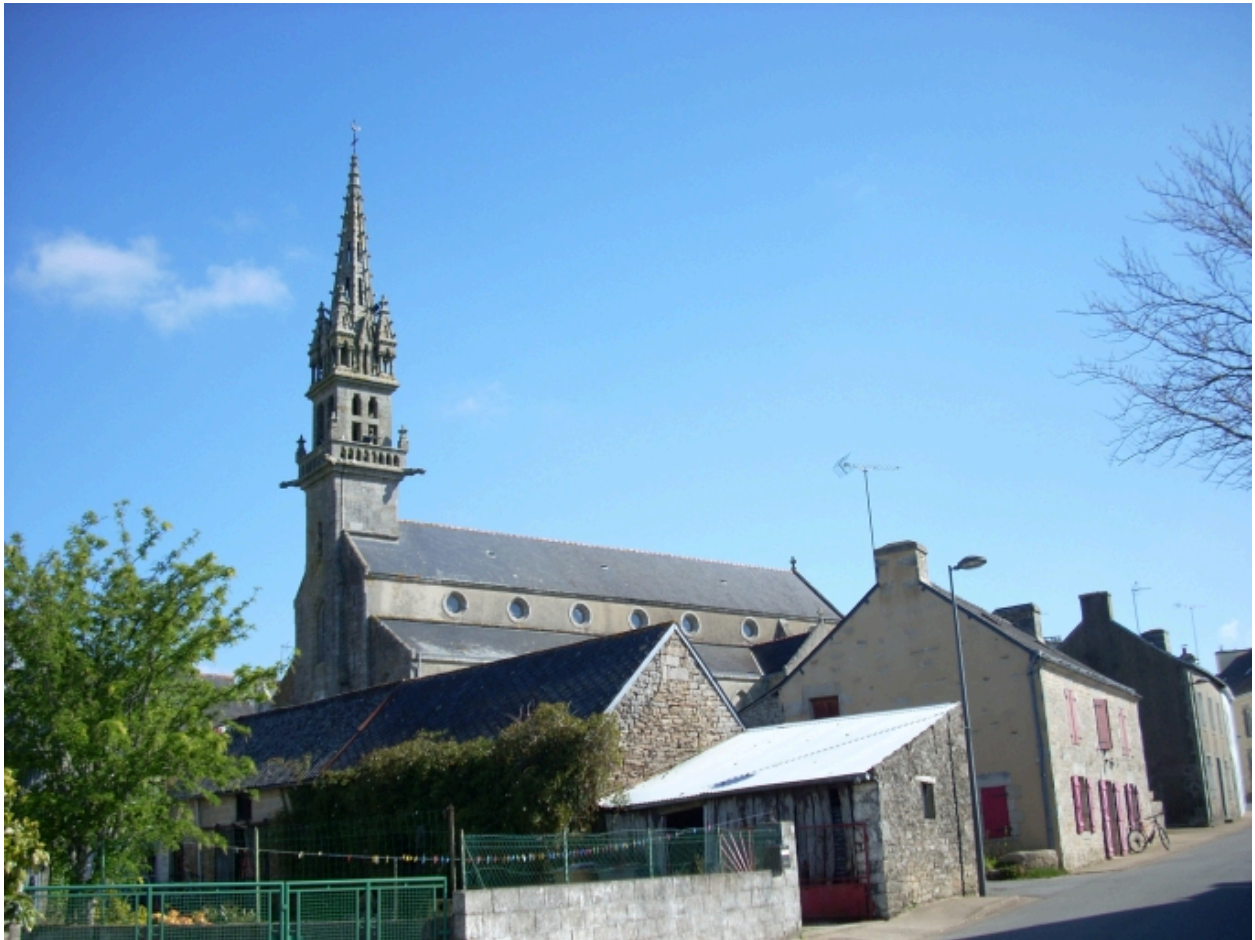
Saint-Thurien, église paroissiale Saint-Thurien : vue de situation depuis le sud-ouest
