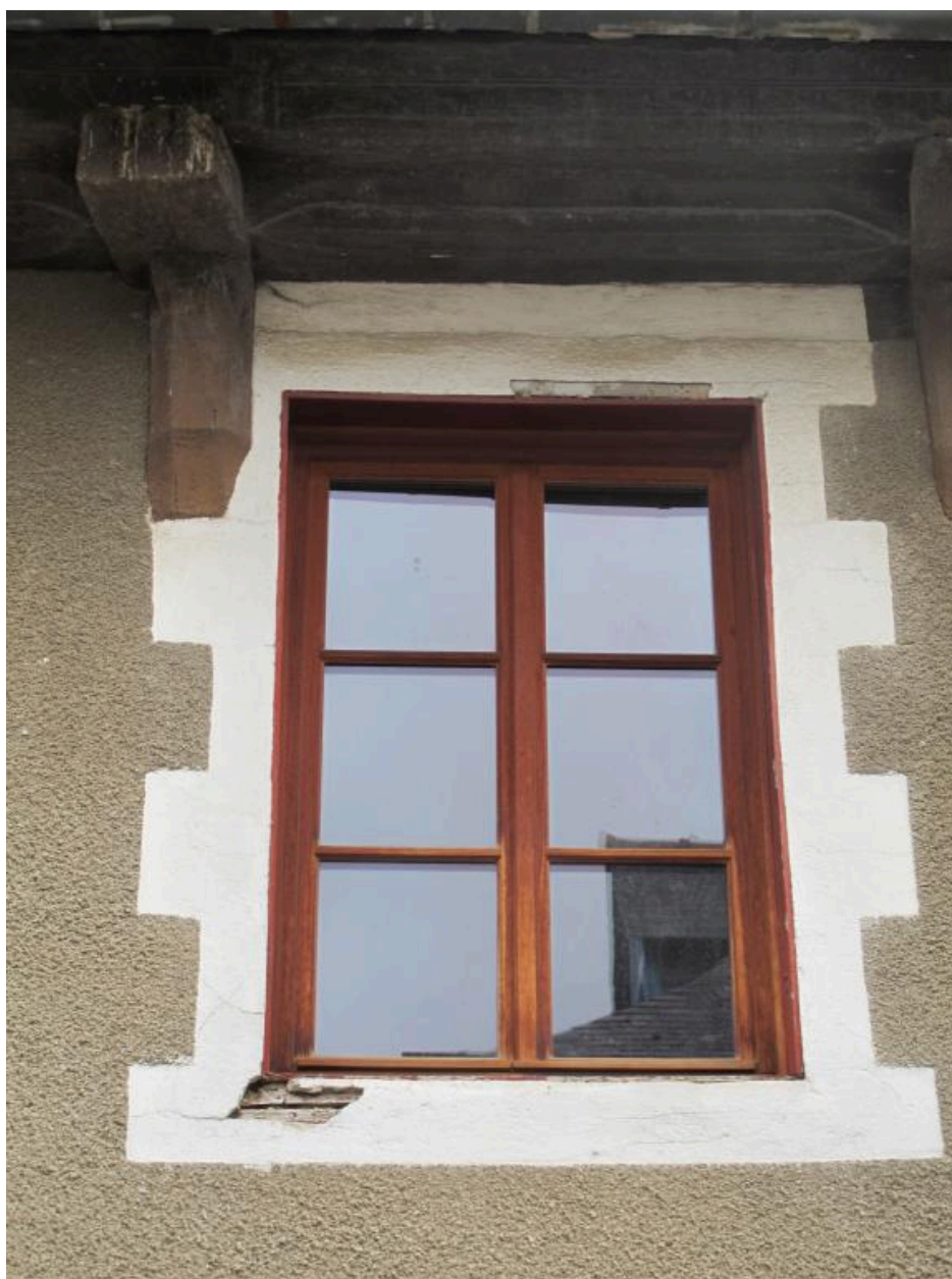
Façade nord. Premier étage, partie ouest, fenêtre
