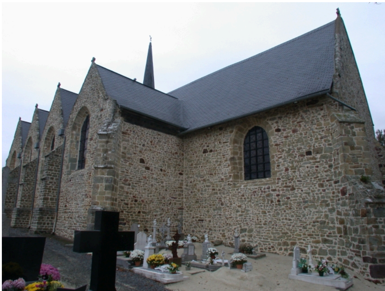
Façade sud et chevet
