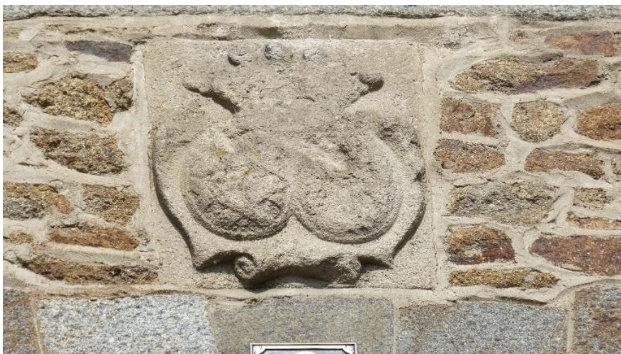
Détails sur la façade est
