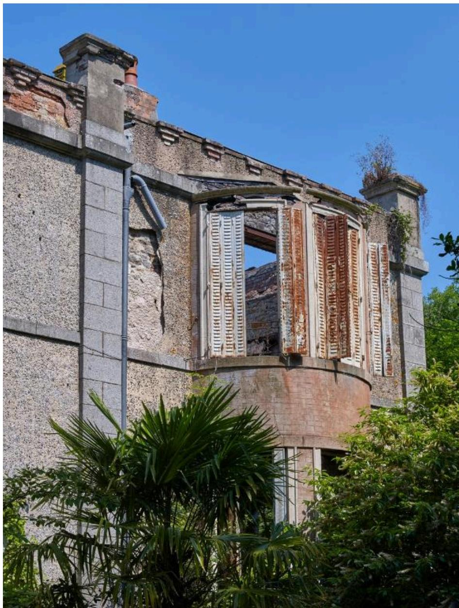
Vue de l'élévation Sud-est : fenêtre en encorbellement (bow-window) du premier étage. Chaînages (faisant pinacles) et bandeau en granite gris viennent souligner l'architecture. Des consoles en pyramide inversée ornent également la partie sommitale
