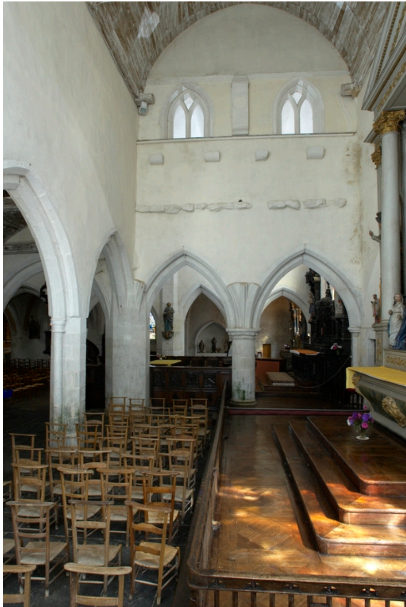
Chapelle sud. Vue générale intérieure sud
