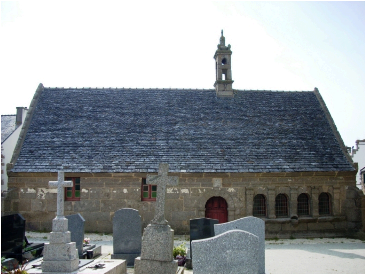
Plouarzel, église paroissiale : élévation est de l'ossuaire
