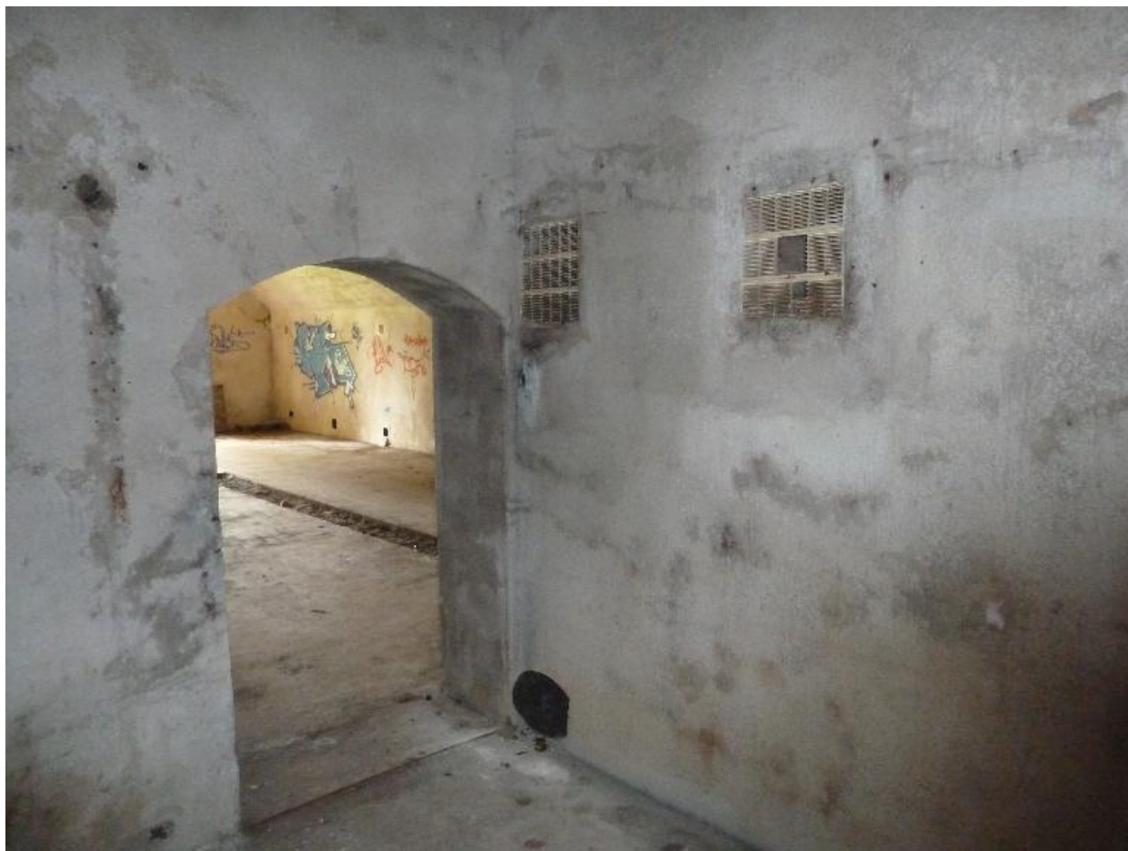
Le Palais, enceinte urbaine, réduit C, bastionnet de droite.
