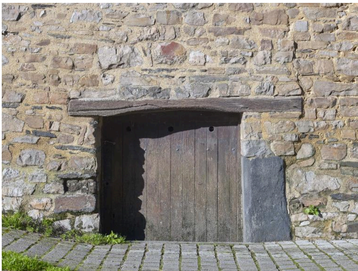
Détail de la porte de la cave occultée en partie par la voirie
