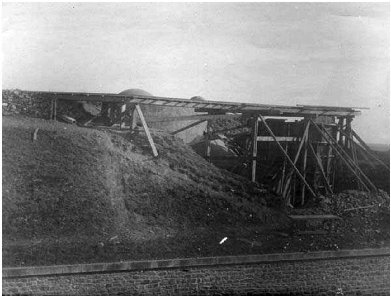
Vue du chantier de construction du réduit, vers 1902-1906 : coffrage du puits de l'une des deux tourelles pour canons de 75 mm. On distingue la tourelle pour canons et l'observatoire à leurs formes arrondies
