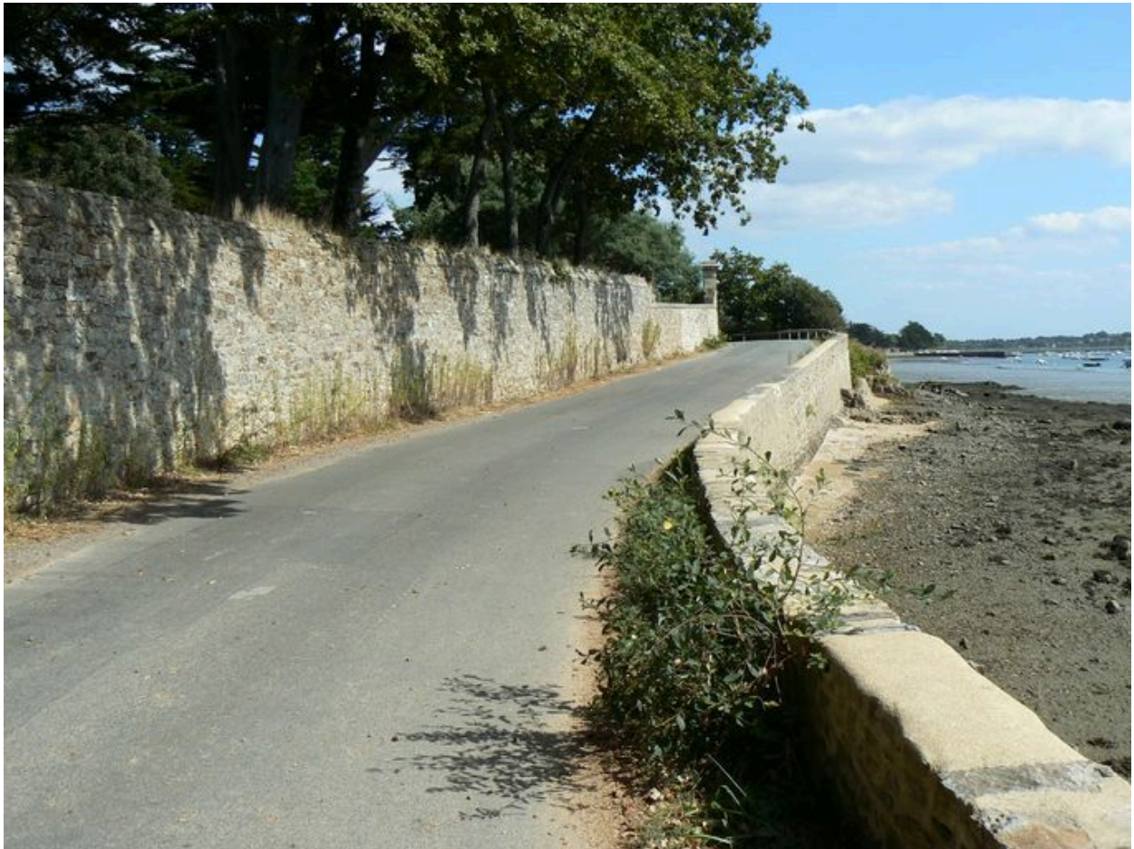
Digue-route du Passage Saint-Armel
