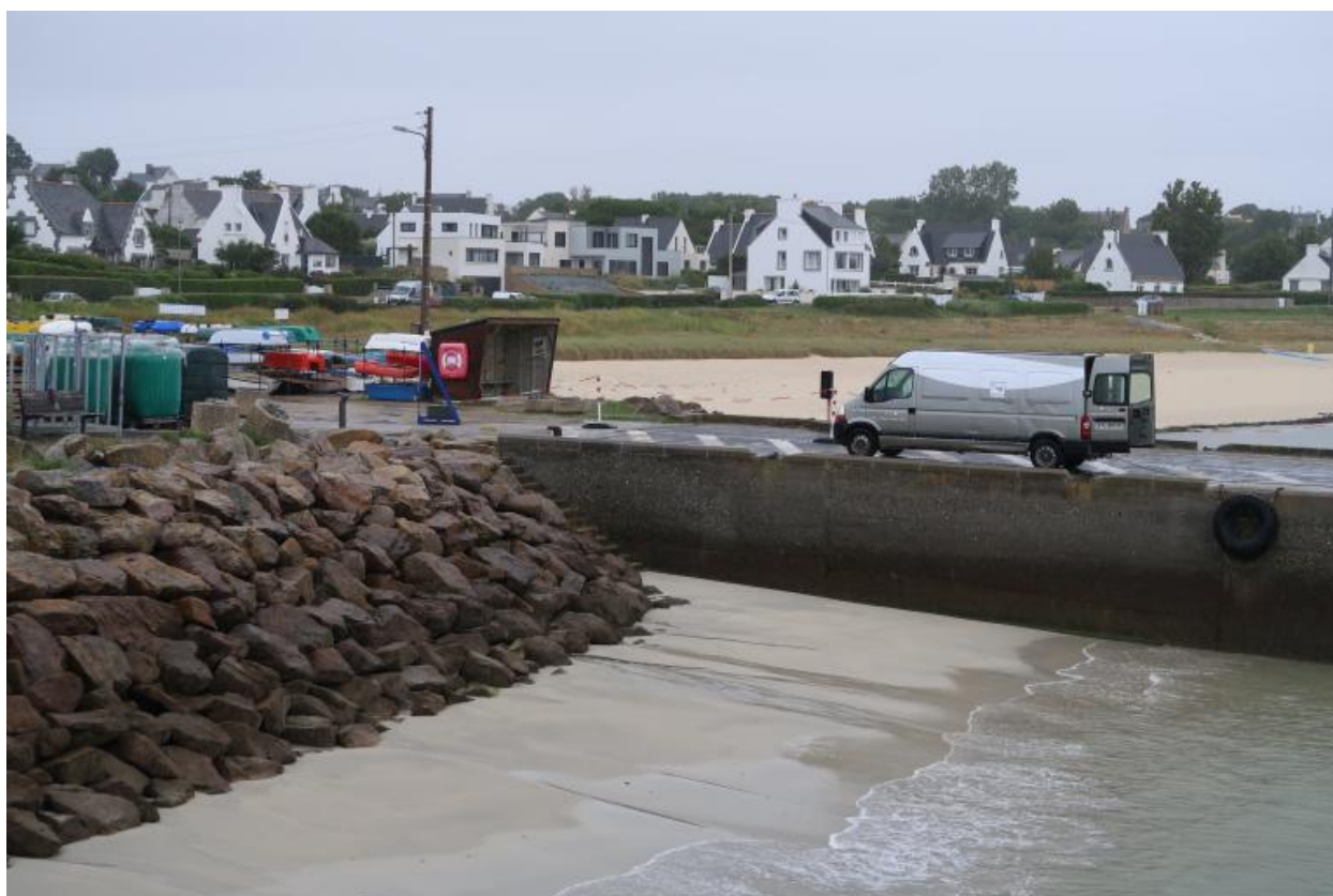
Cale de Sainte-Evette, jonction entre cale, plage et enrochement
