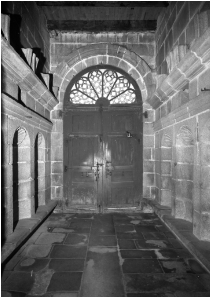
Châteauneuf-du-Faou, église paroissiale Saint-Julien et Notre-Dame : rez-de-chaussée de la tour, état en 1967
