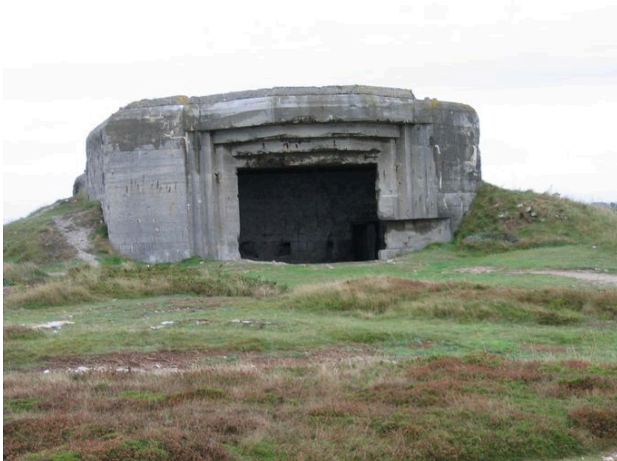
Casemate de la batterie lourde allemande
