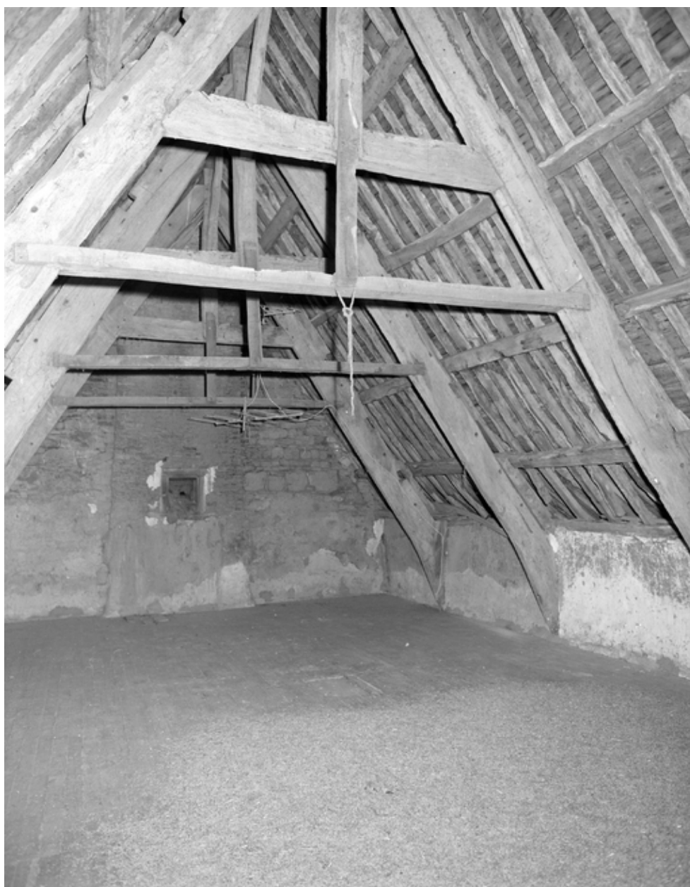
Aile nord-sud : charpente
