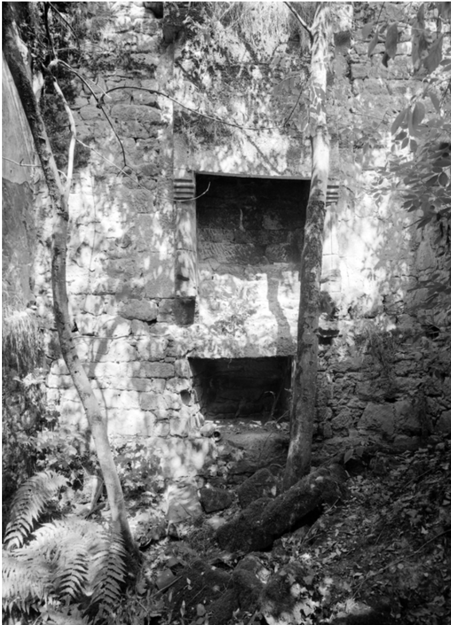
Ancien manoir , vue du pignon ouest, vestiges de cheminée, état en 1967
