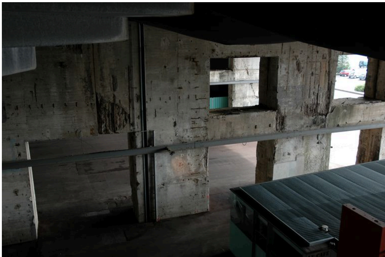
Vue de l'intérieur de la base de sous-marins : descente par le nouvel escalier
