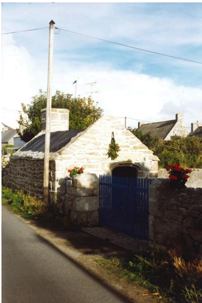
Four à pain situé le long de la départementale, pignon ouest. (1999)
