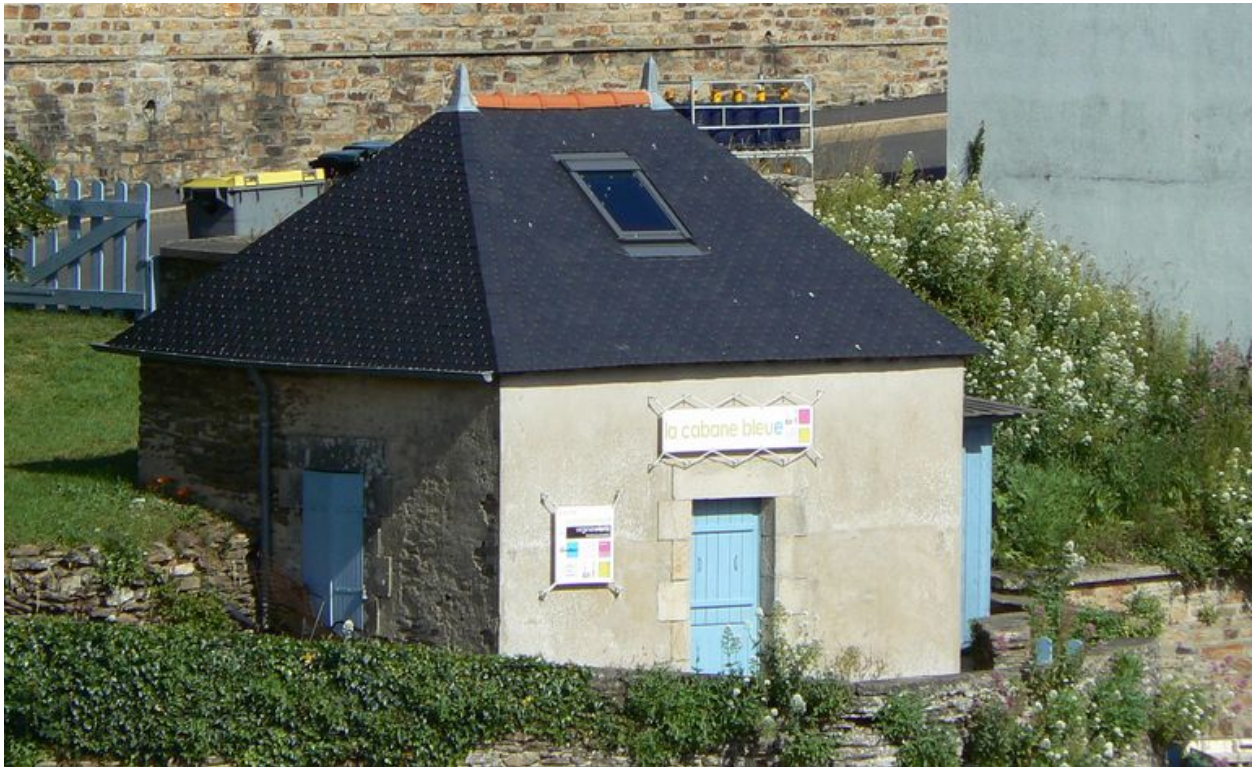
Corps de garde aval
