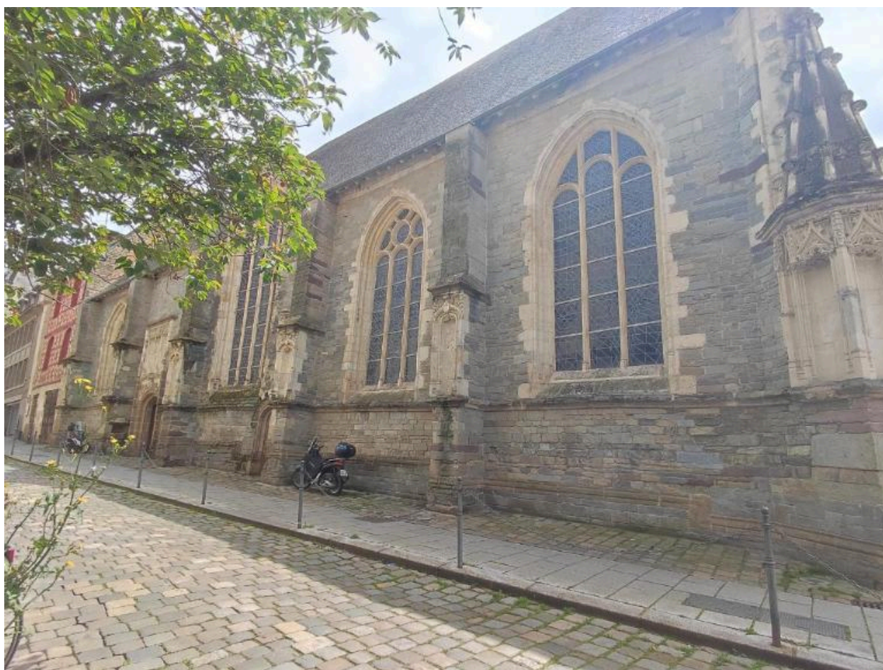
Vue de la façade nord
