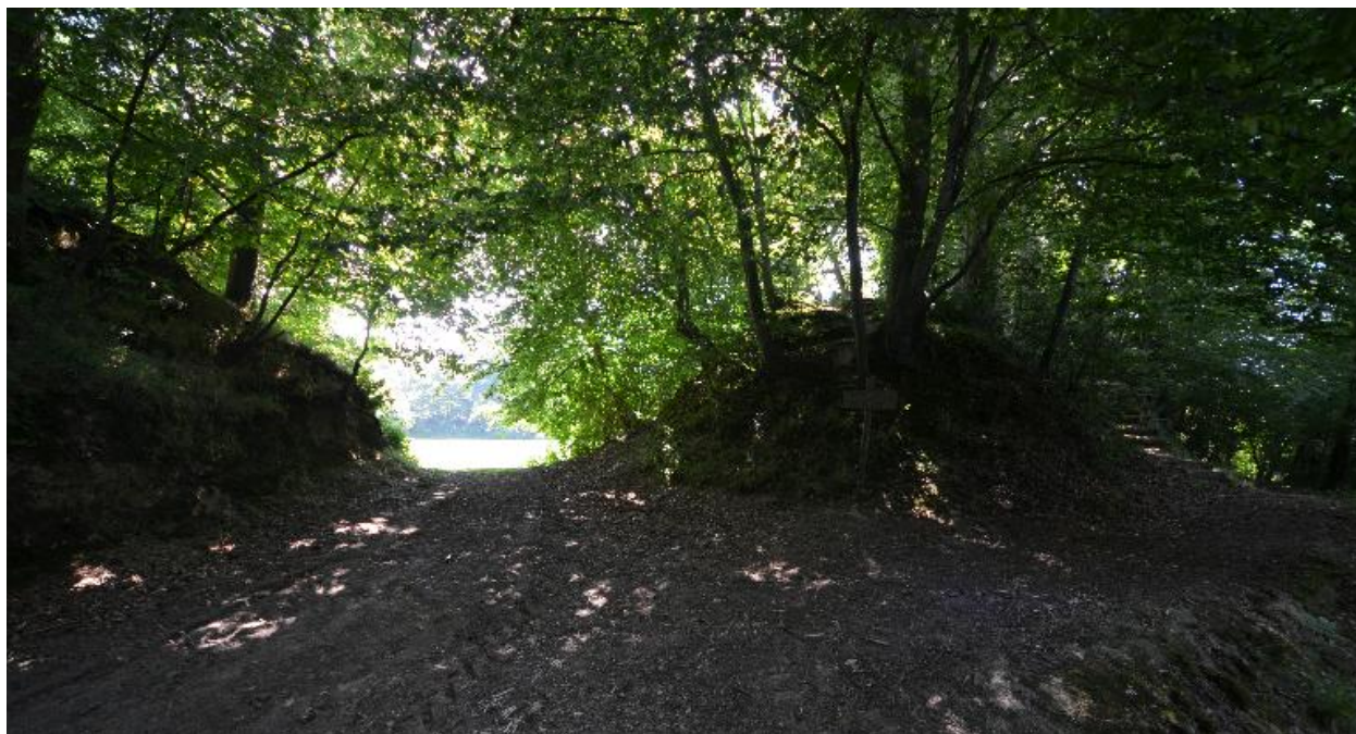
Vue de l'enceinte percée au nord (état en 2013)
