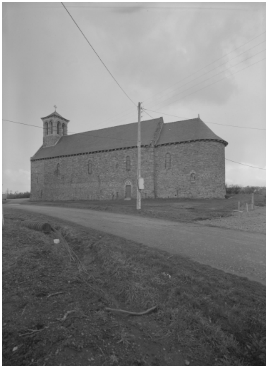
Elévation Sud : vue générale
