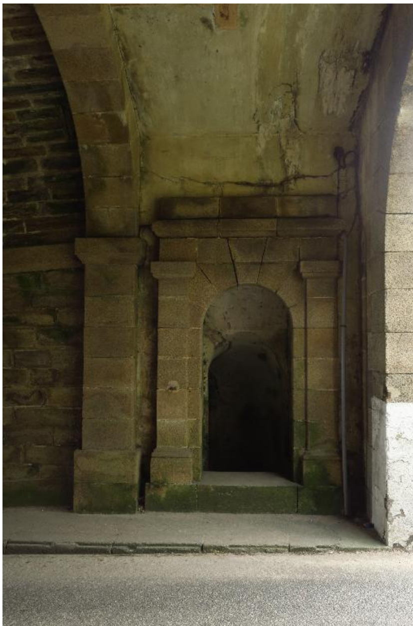
Le Palais, enceinte urbaine, porte Vauban, accès au sous-sol.
