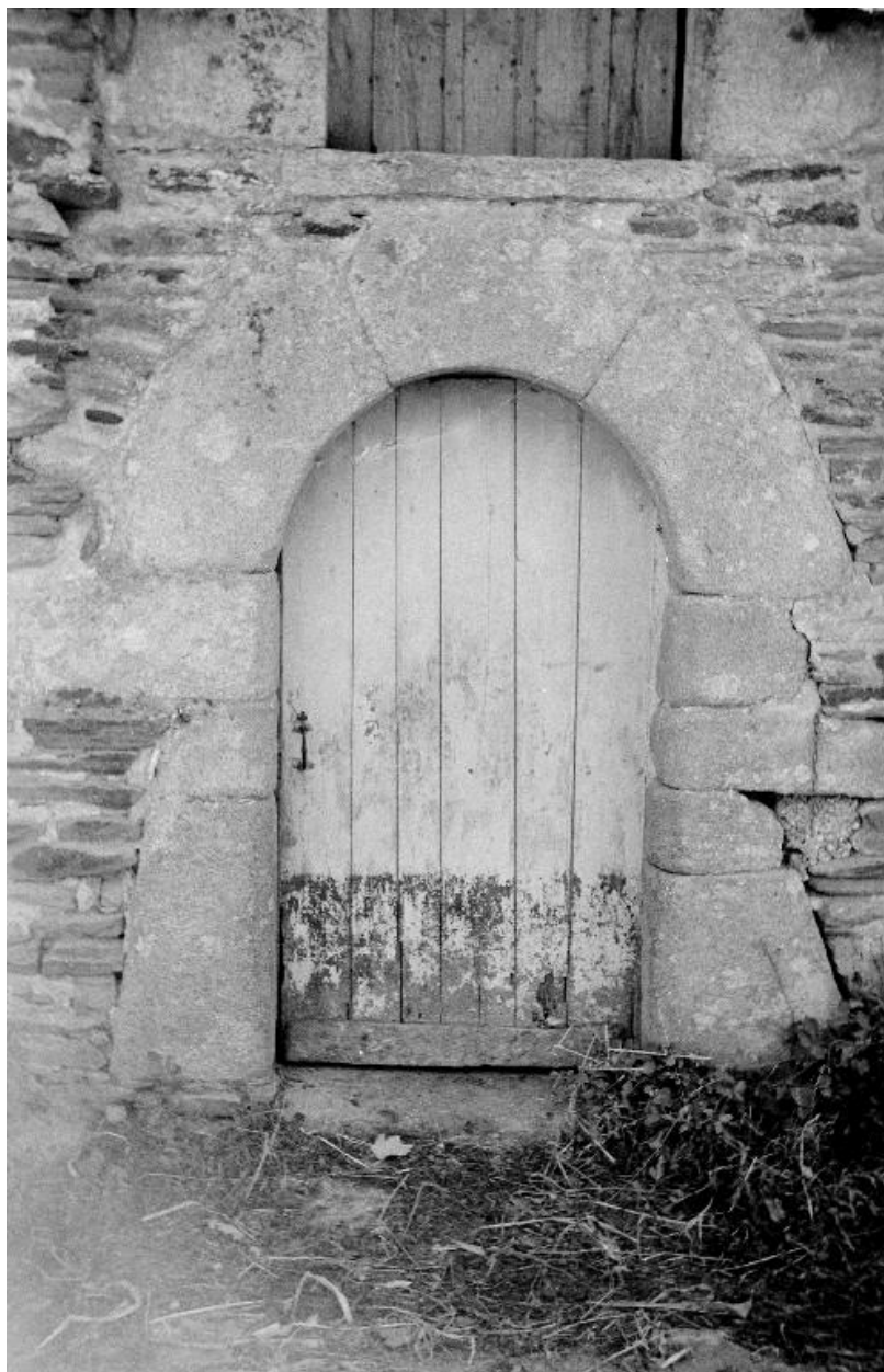
Ferme 2 : la porte (état en 1969)
