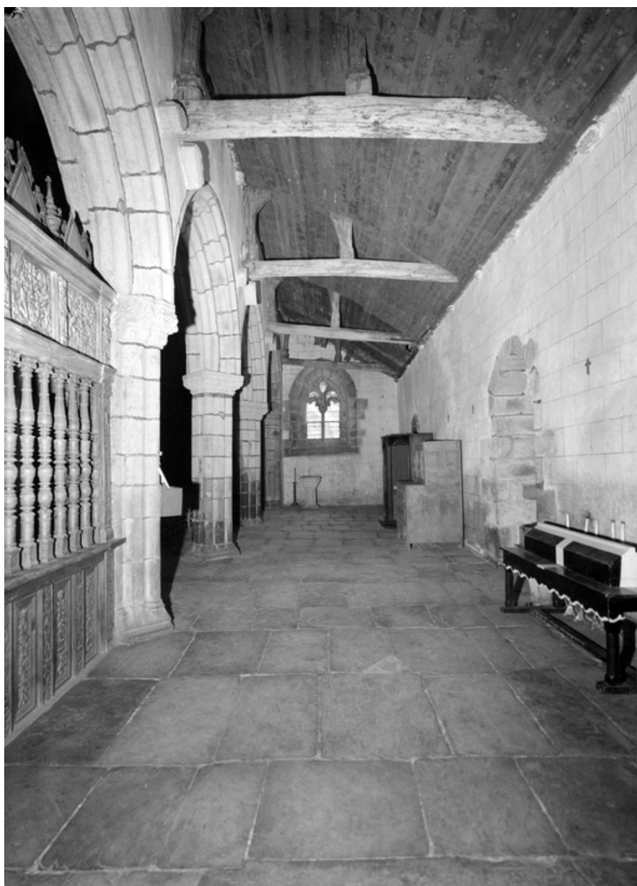
Bas-côté nord, vue générale vers l'ouest
