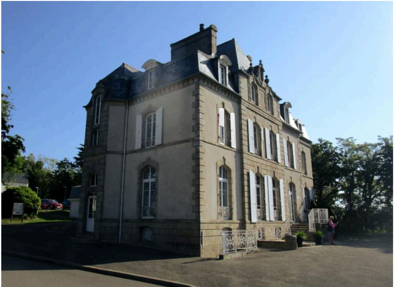
Vue générale prise du sud-ouest. (2023)
