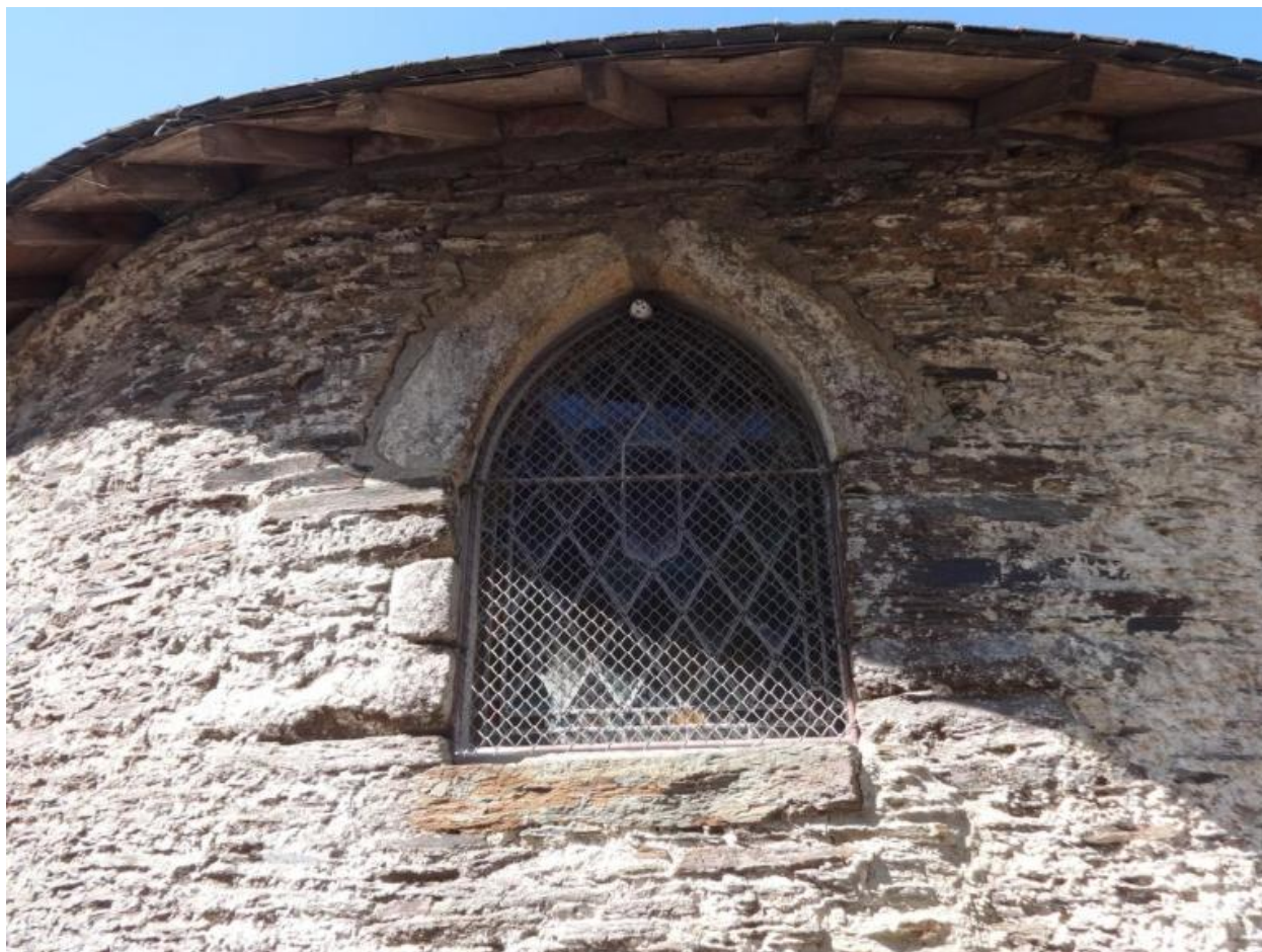
Détail, élévation nord
