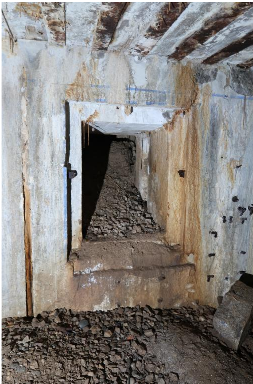
Vue de la sortie de secours de la pièce de vue - chambre de troupe (état en 2021). Sur le mur, liseré de couleur bleue faisant frise
