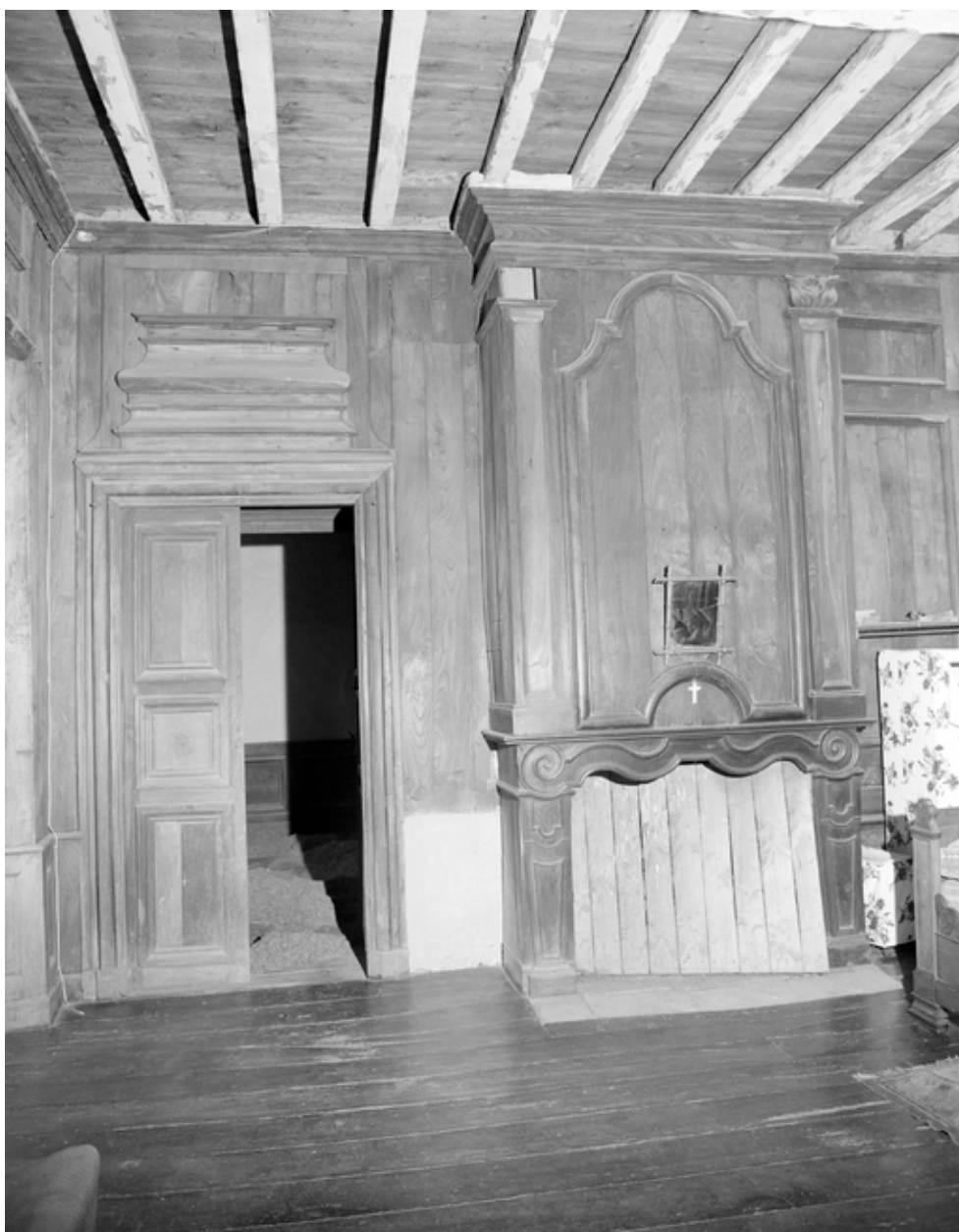
Premier étage : cheminée, pièce sud-est
