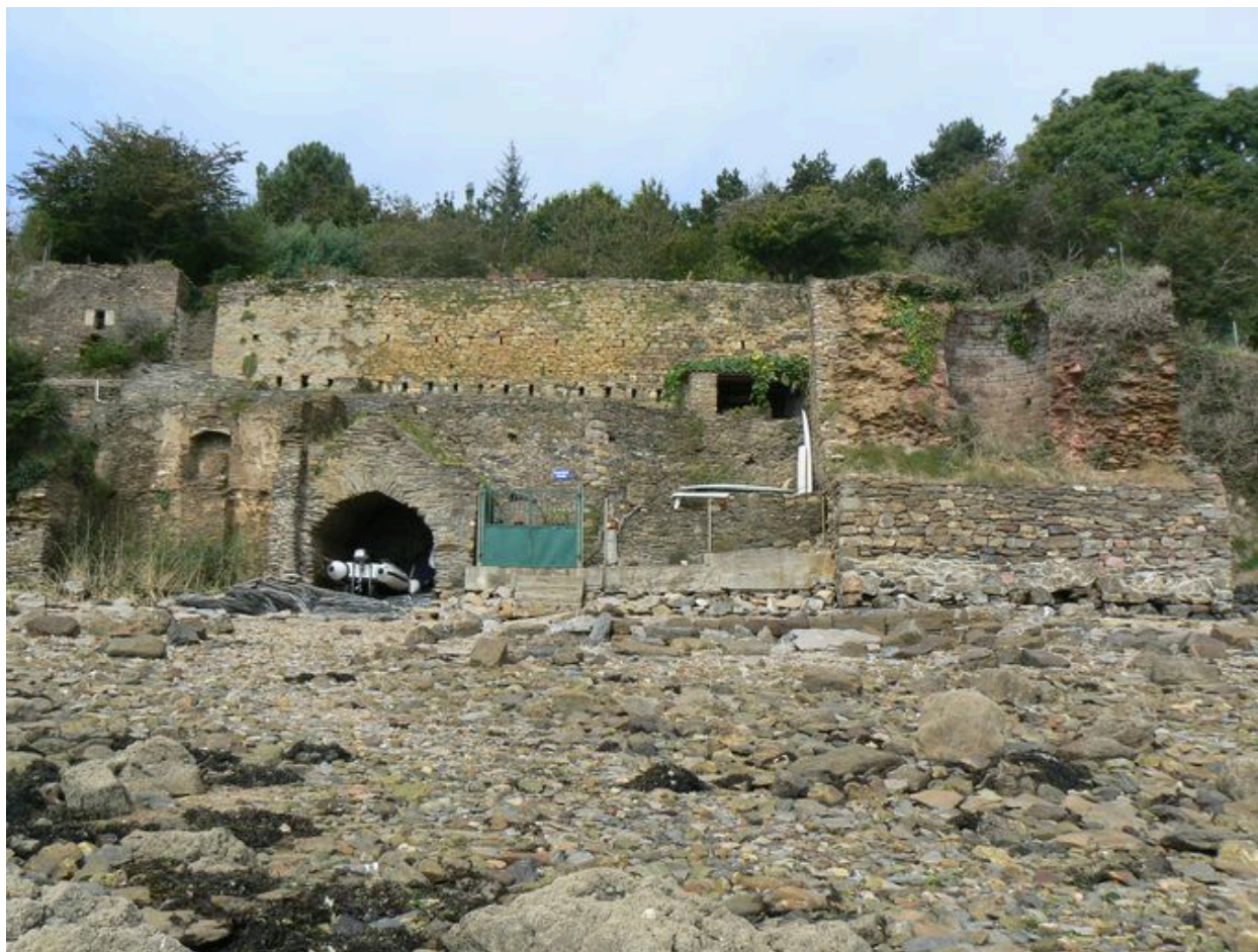
Vue générale du four à chaux de Postermen
