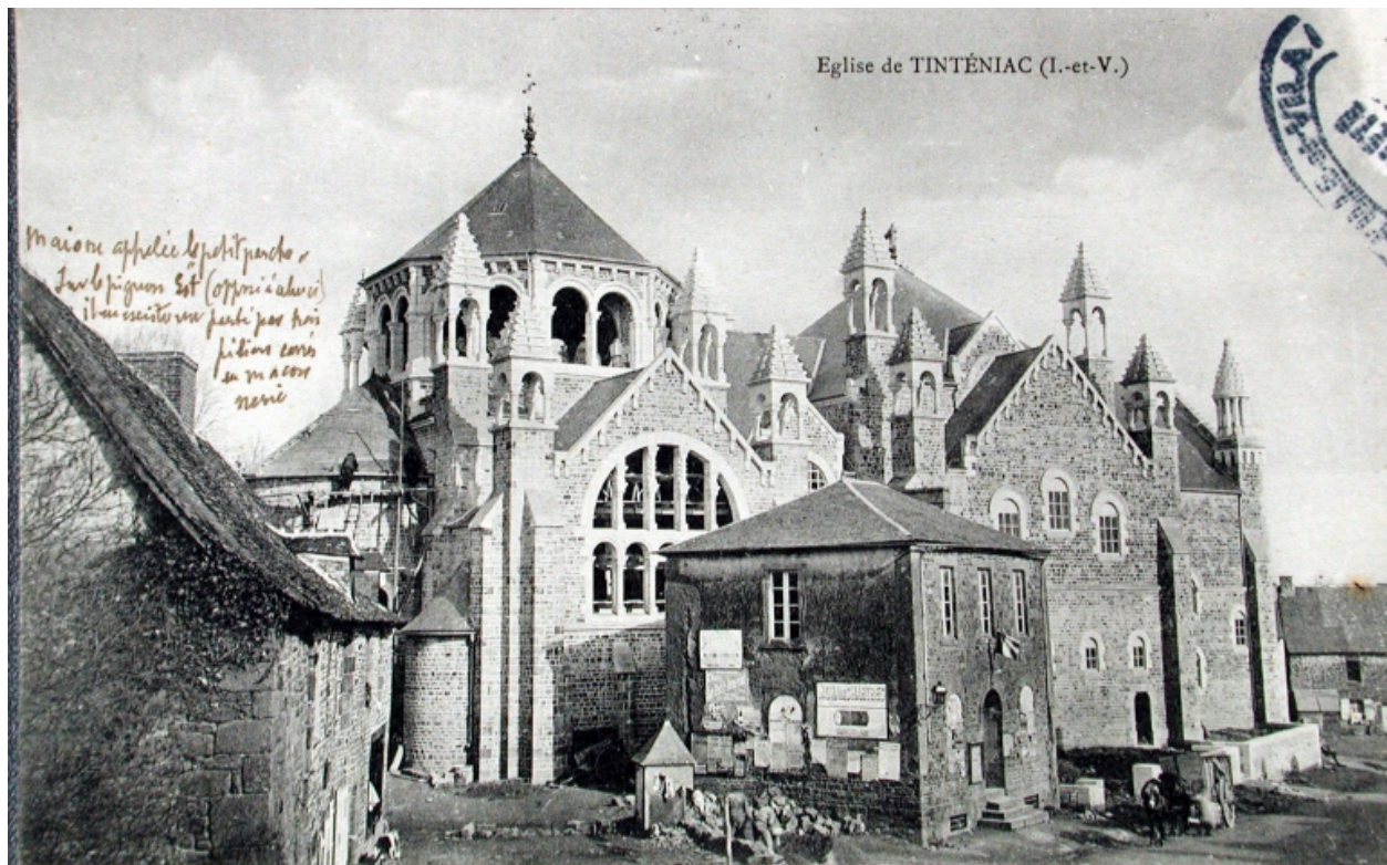
Construction de l'église
