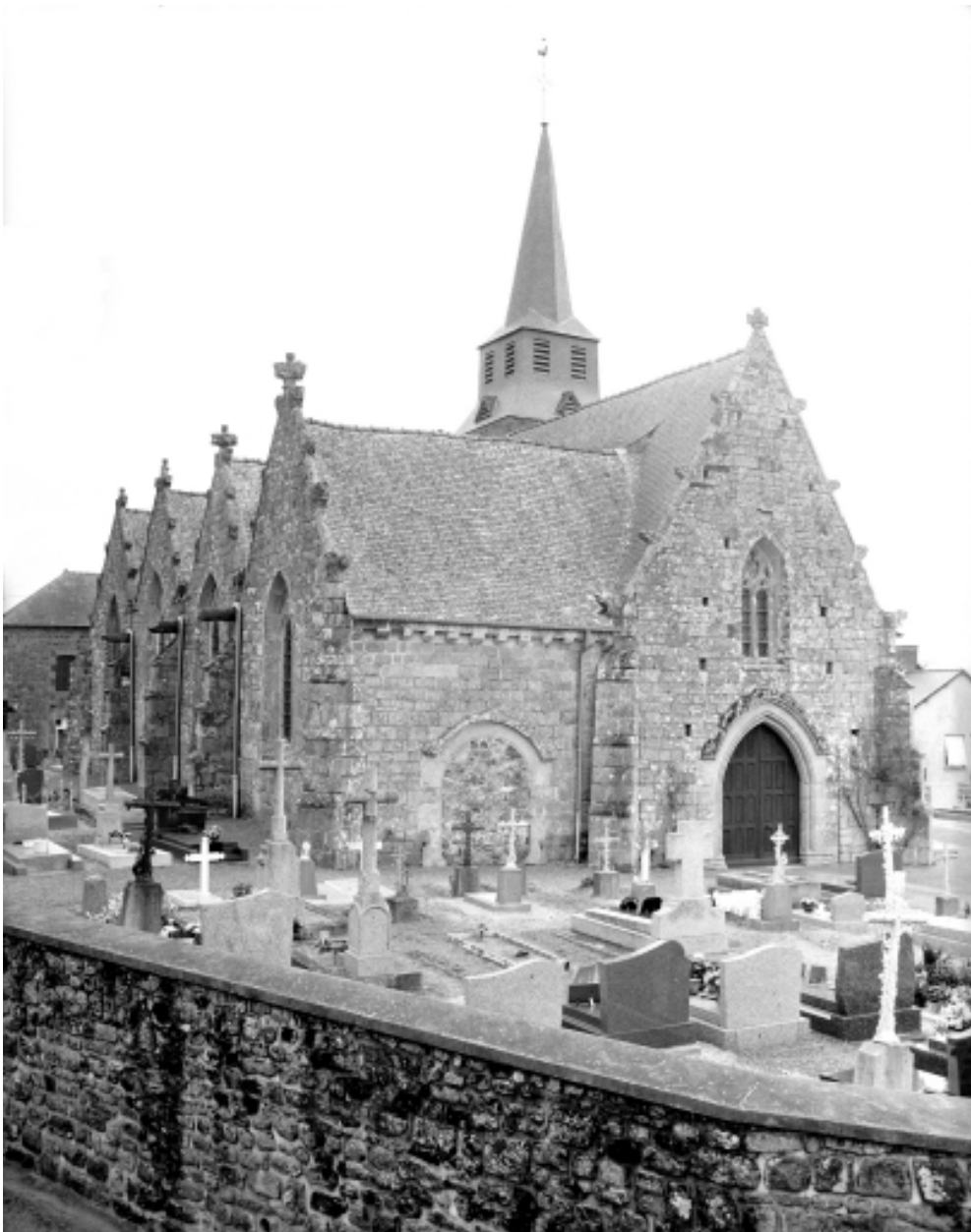
Elévation Nord-Ouest : vue générale
