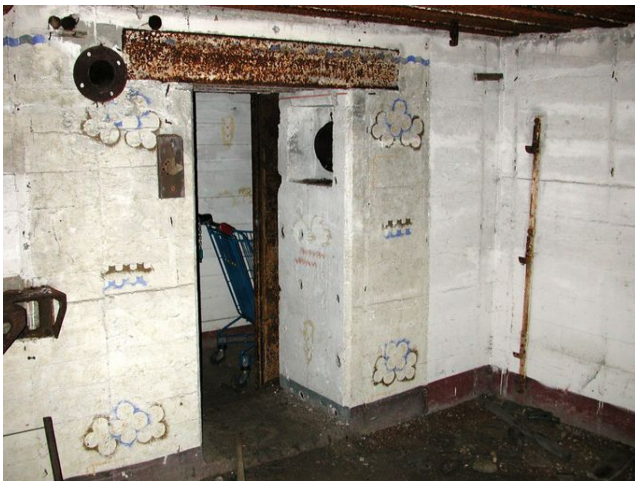
Vue du bunker - abri à personnel de type 128 des Quatre-Pompes : peinture murale allemande dans le style tapisserie (réalisée au pochoir)
