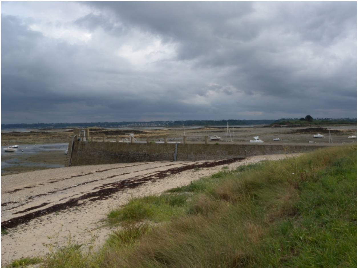
Vue générale de la jetée dans son environnement
