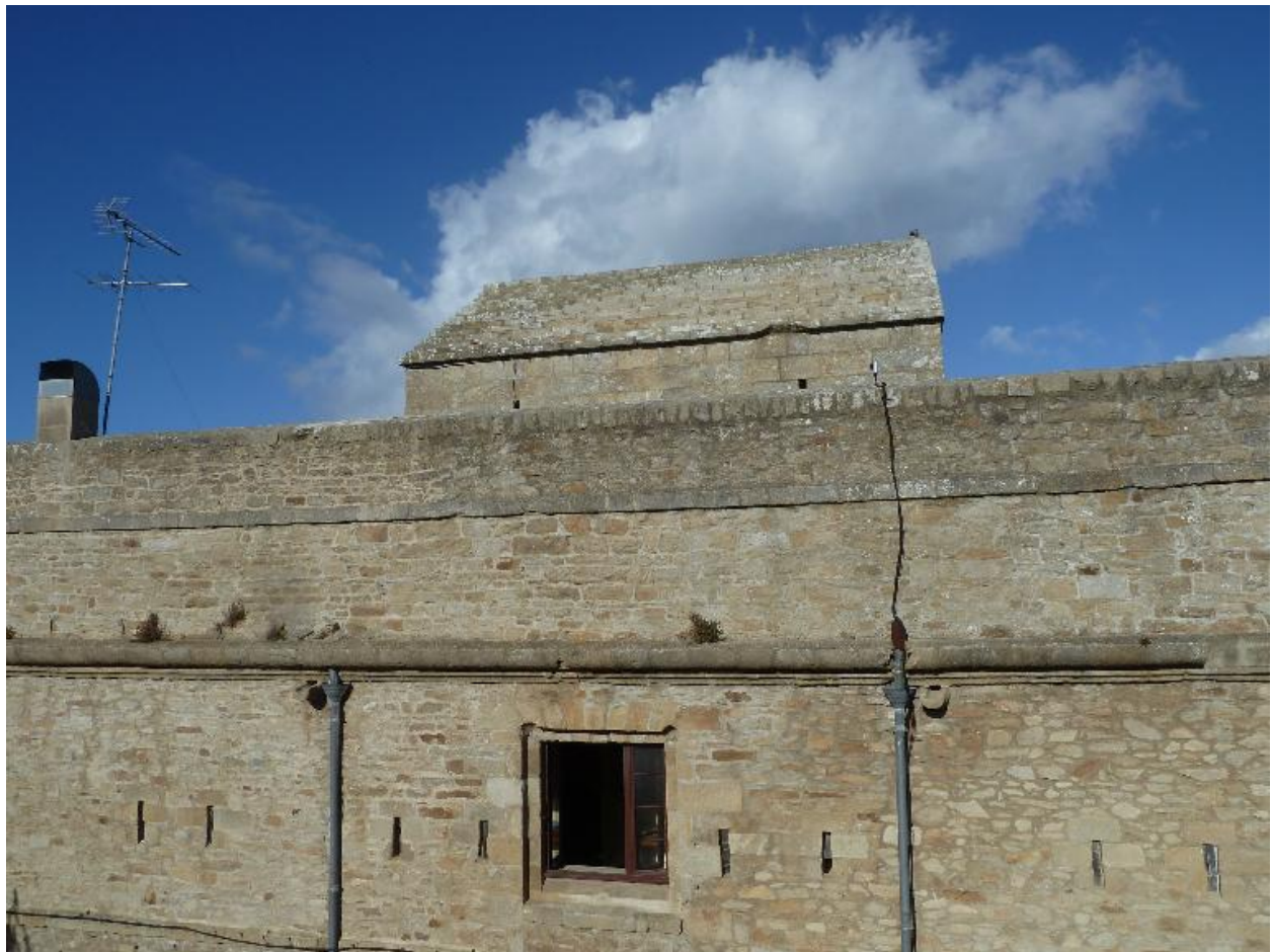
Saint-Pierre-Quiberon, fort de Penthievre, caserne défensive, façade sud-est.
