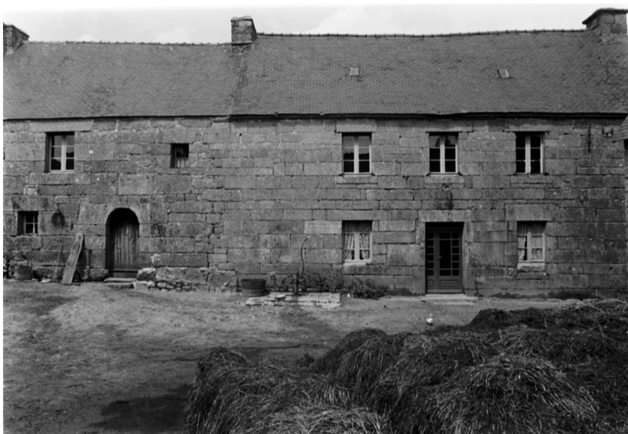
Face sud du logis principal
