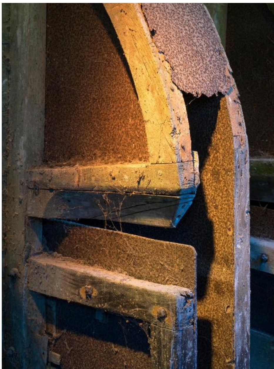
Bâtiment principal. Salle 3. Détail d'un poste à espader. Détail
