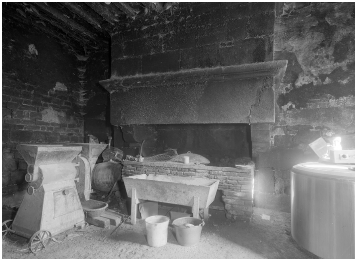
Logis C : cheminée, rez-de-chaussée, mur pignon nord
