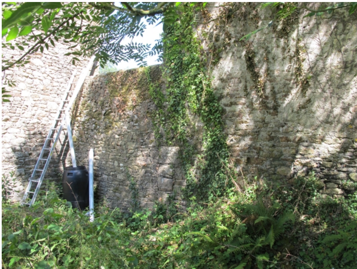
Détail du mur de clôture reliant le logis et le corps ouest
