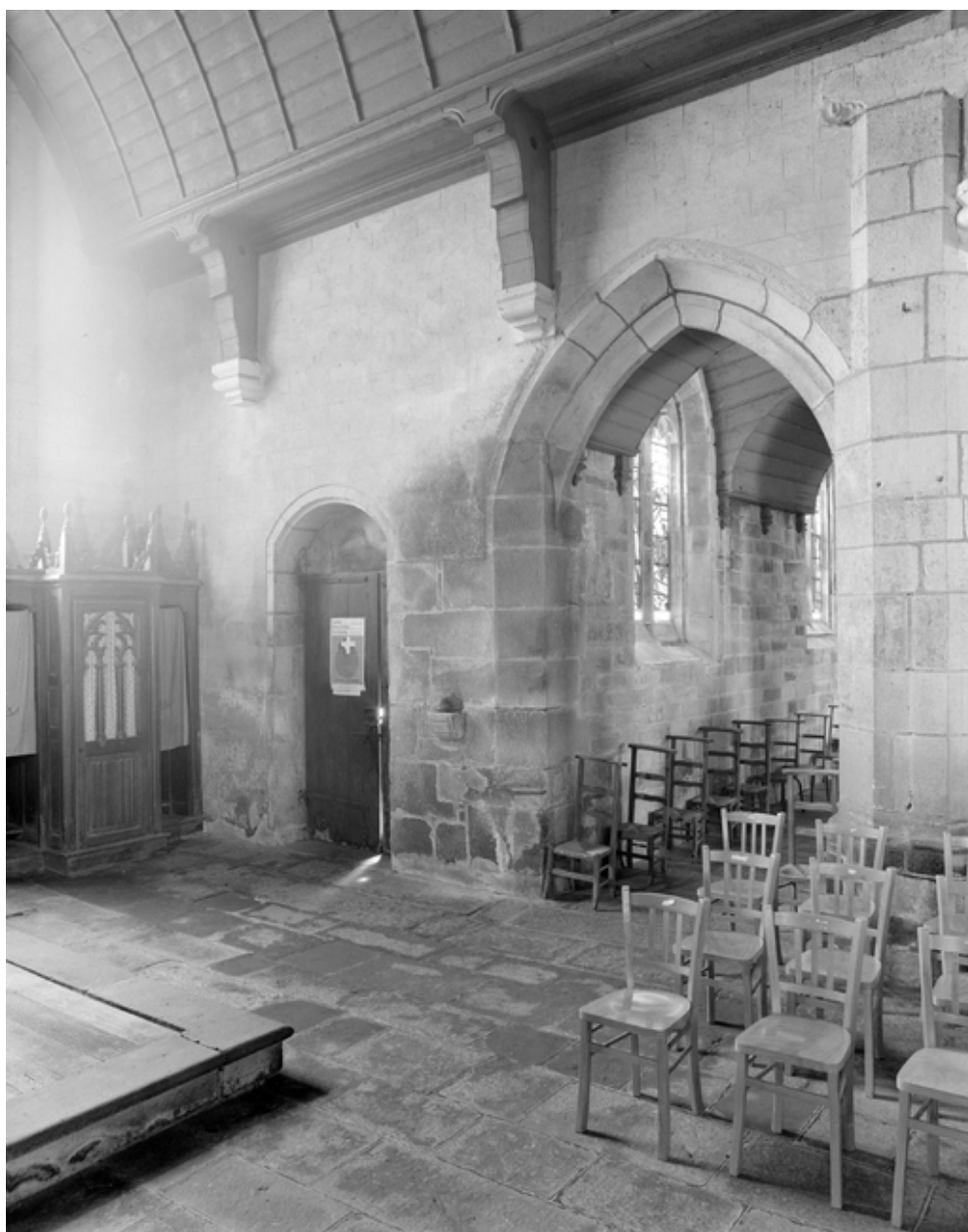
Vue intérieur : détail mur ouest du bras sud
