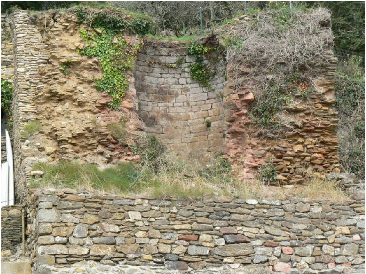
Détail du four à chaux de Postermen
