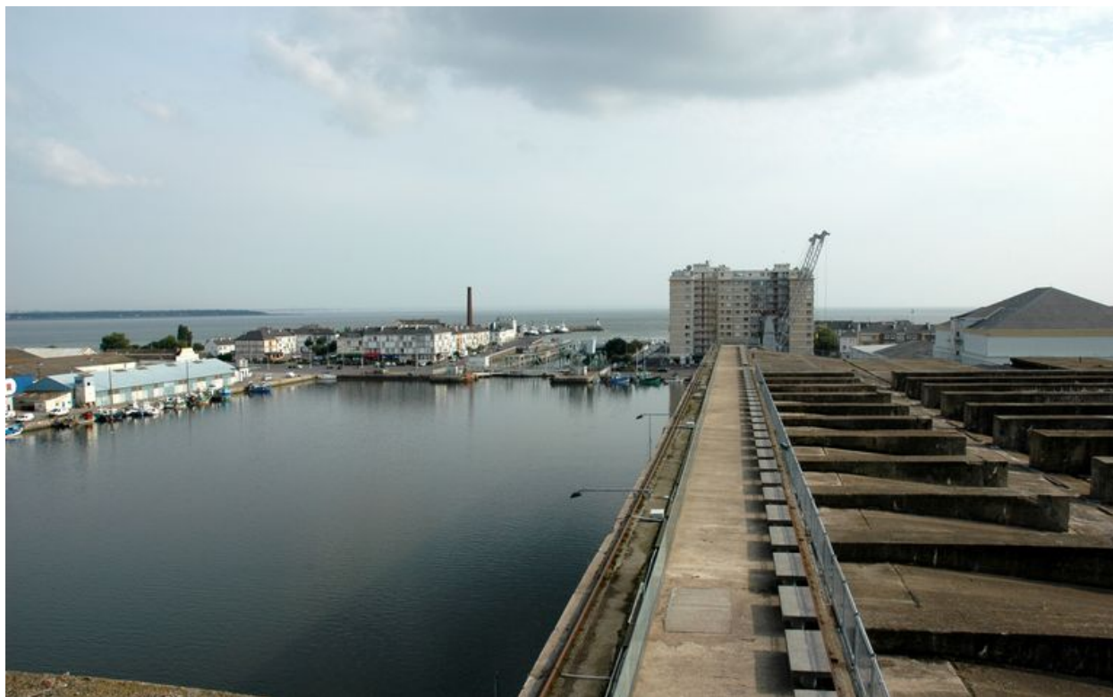
Environnement industrialo-portuaire de la base de sous-mains de Saint-Nazaire depuis la terrasse
