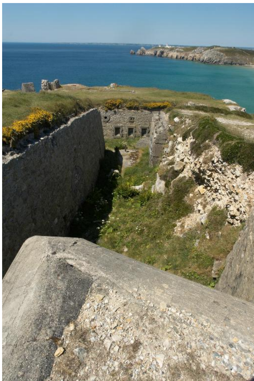
Vue de l'extrémité de la batterie de mortier : abri double sous traverse en maçonnerie
