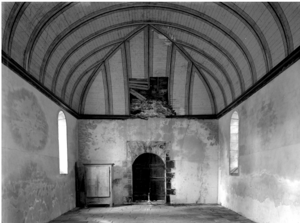
Intérieur, vue vers l'ouest. Etat en 1968
