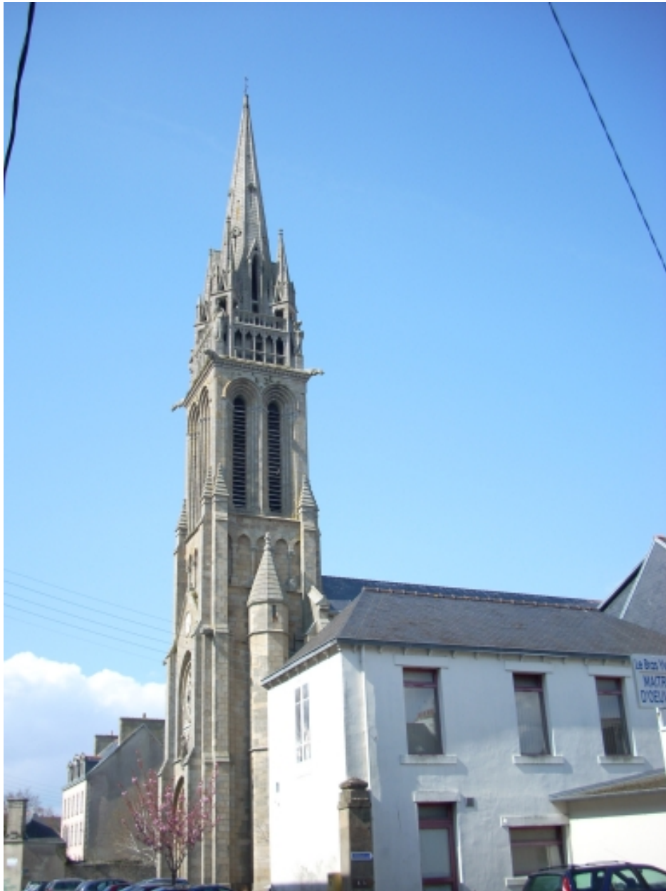
Douarnenez, église du Sacré-Coeur : vue générale sud-ouest
