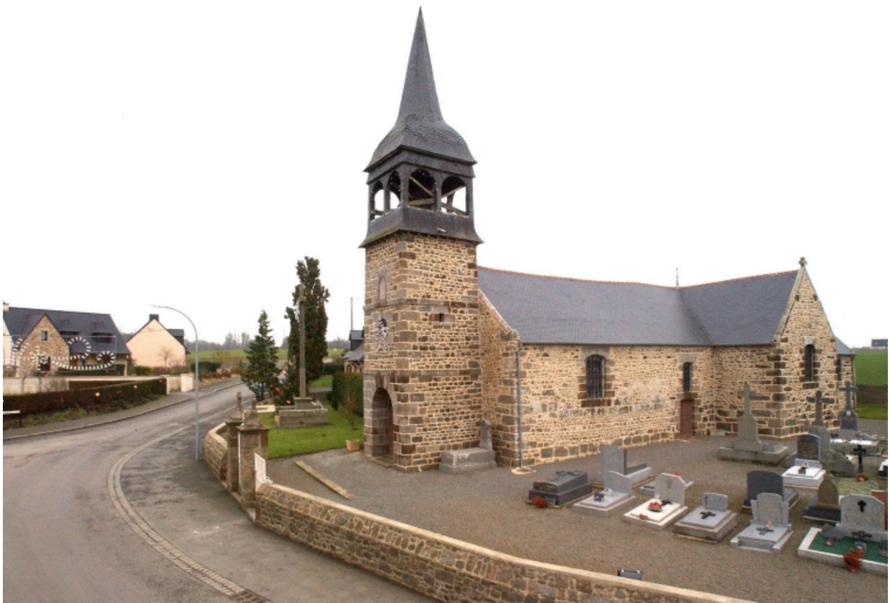
L'église Saint-Martin et son enclos : vue de situation sud-ouest
