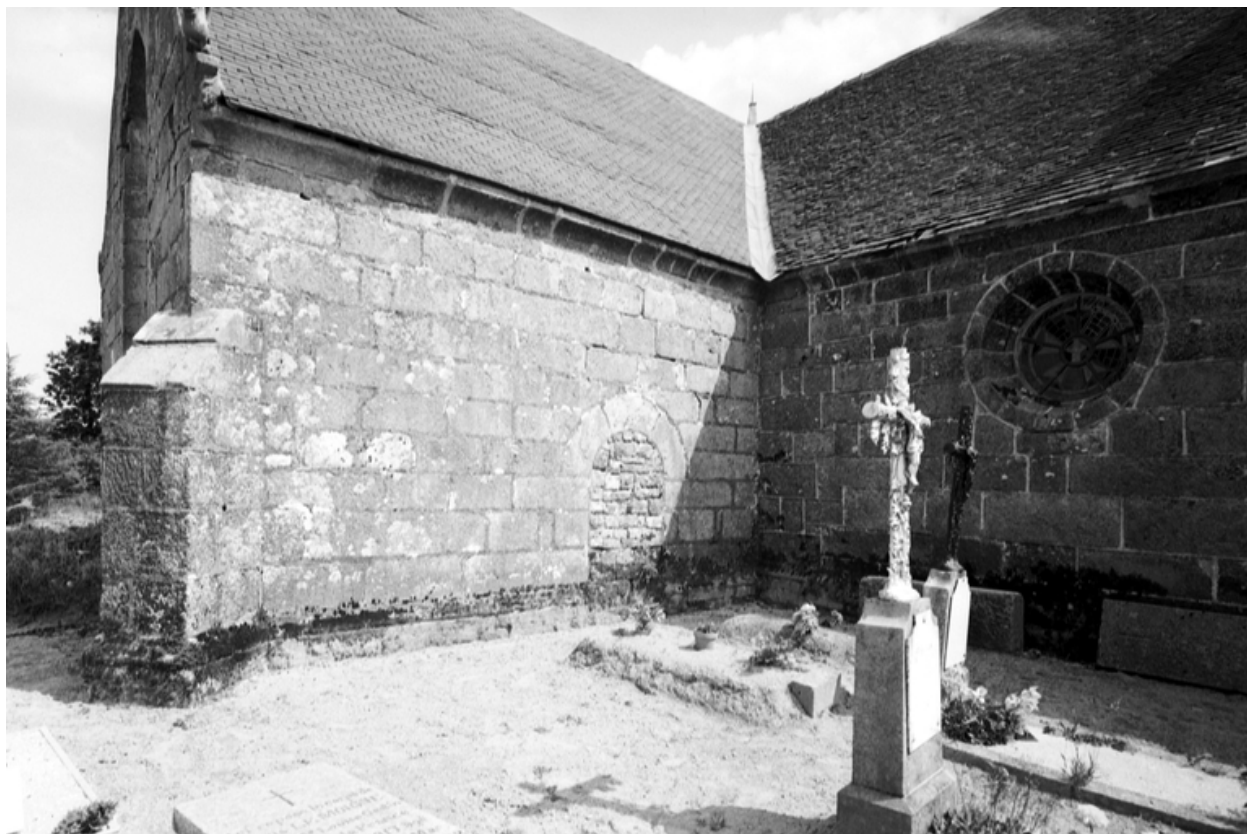
Vue nord ouest, détail des ouvertures
