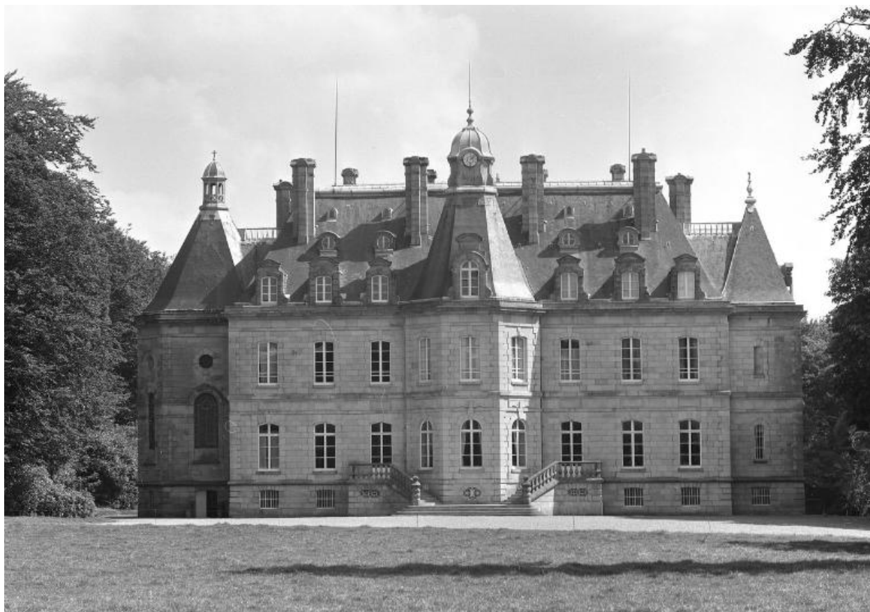
Logis, élévation ouest : vue générale
