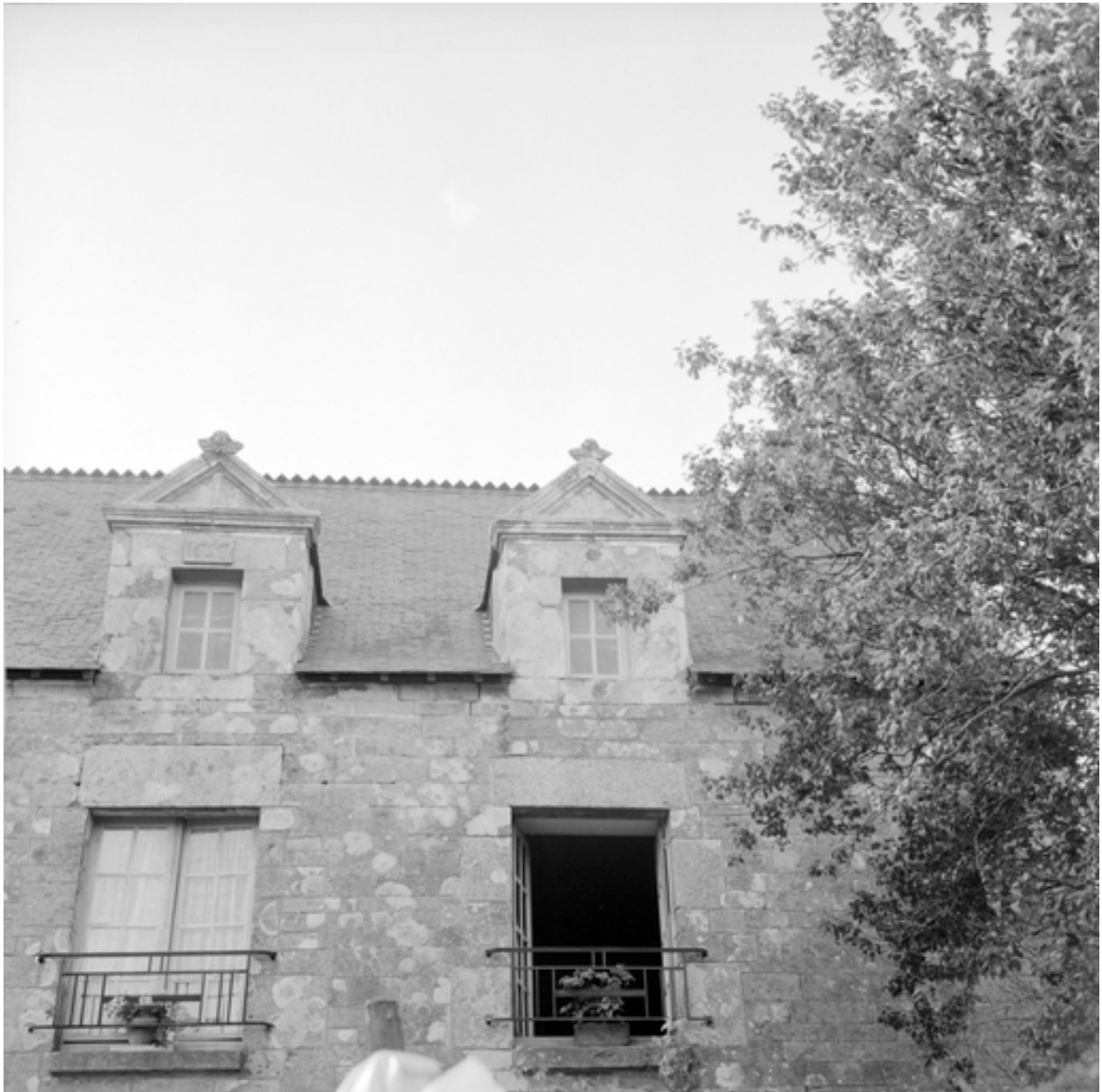
Linguenec, maison : lucarnes de la façade sud-est
